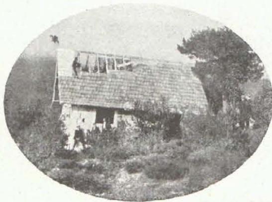
Construcción del «Twenty Club»
