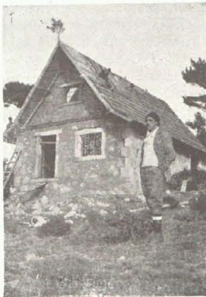
El «Twenty Club» en construcción. 1909
