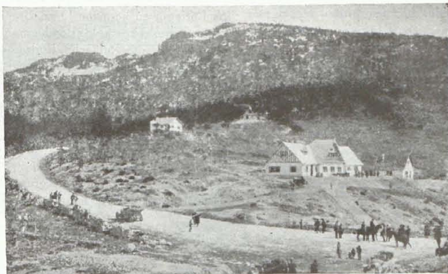
El «chalet» del C. A. E. y Agrupaciones «Twenty», B y C, en 1911. Carretera de Villalba á La Granja, kilómetro 16,600
